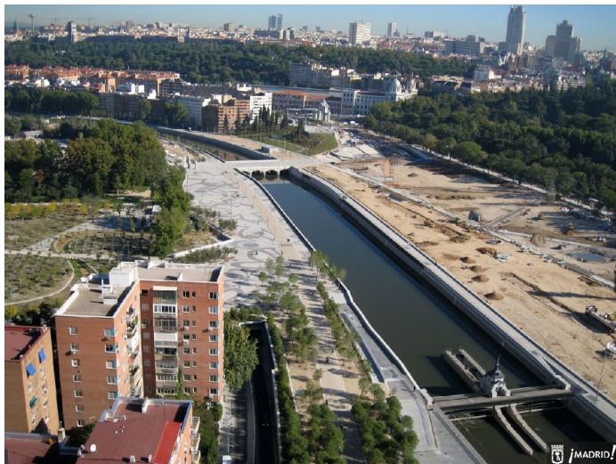
Madrid, Puente del Rey après l'aménagement du Madrid Río, partiellement en travaux sur l'une des deux rives (zone Nord), 2010. La circulation automobile est enfouie sous les quais, dégageant en surface la création de vastes espaces publics dédiés aux usagers lents (piétons, vélos, etc.), appropriables par les habitants des quartiers voisins. La circulation automobile est conservée en surface pour la desserte locale. Crédit image : http://www.madrid.es
