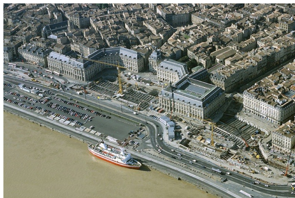
Bordeaux, les quais de la Garonne pendant les travaux de réaménagement, alors monopolisés par le parage et la circulation automobile. Crédit image : http://corajoudmichel.nerim.net
