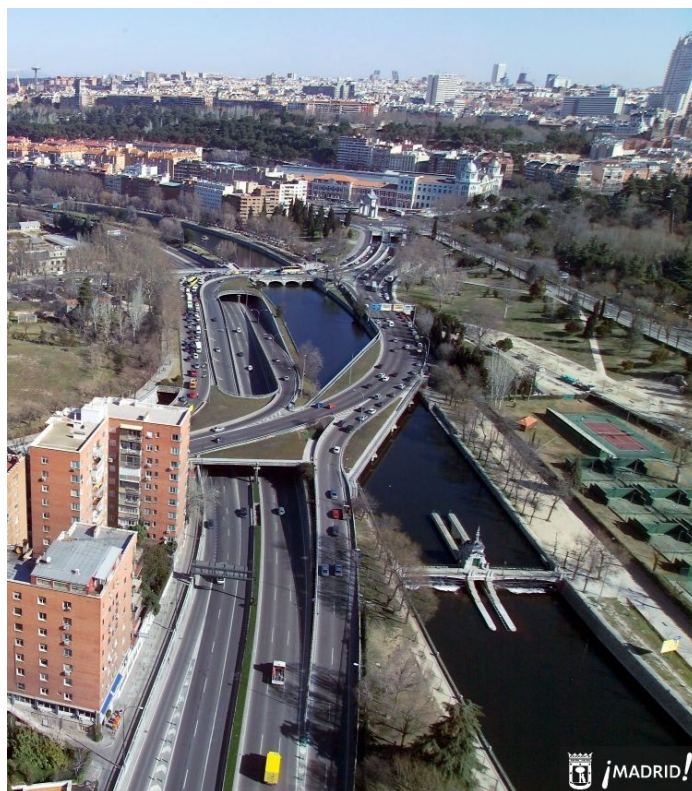
Madrid, Puente del Rey avant l'aménagement du Madrid Río (zone Nord), 2005. Les quais sont monopolisés par la circulation automobile et d'importants ouvrages d'art qui lui sont dédiés ; une situation comparable à celle que l'on connaît à Liège sur les rives fluviales. Crédit image : http://www.madrid.es/
