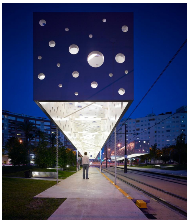
La station Rotonda de Sergio Cardell du tram d'Alicante, 2007. Lauréats du concours d'architecture : SUBARQUITECTURA - Andrés Silanes, Fernando Valderrama, Carlos Bañon (architectes). Source photo : http://www.archdaily.com/1809/tram-stop-in-alicante-subarquitectura/
