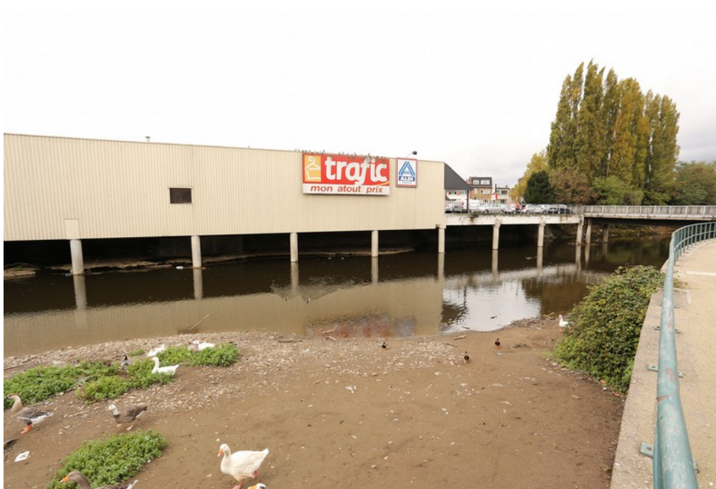
Immeuble commercial surplombant la Vesdre.
