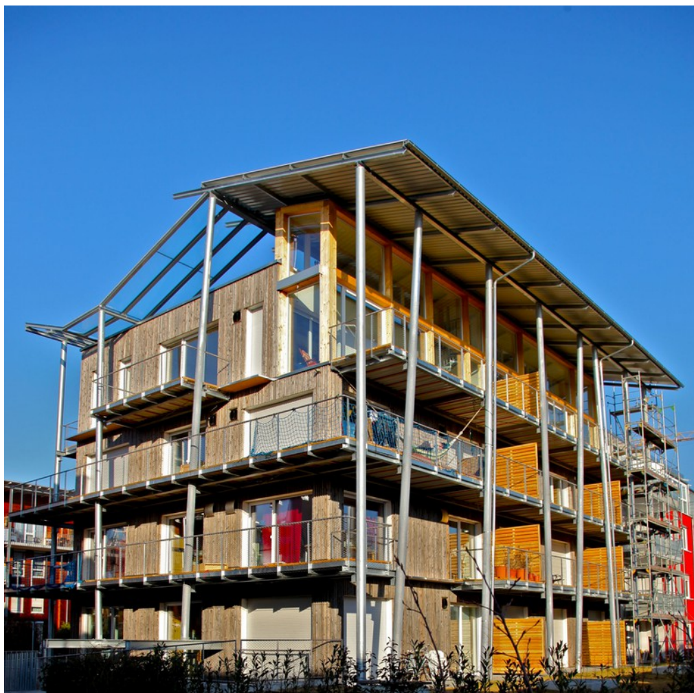
Freiburg, quartier de Riesefeld, construction en bois. Architecte : Wolfgang Frey. Source : sto.de
