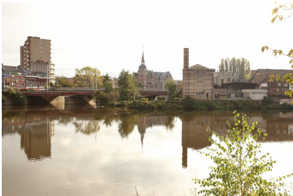
Le Pont de Chênée, vue depuis l'Île aux Corsaires
