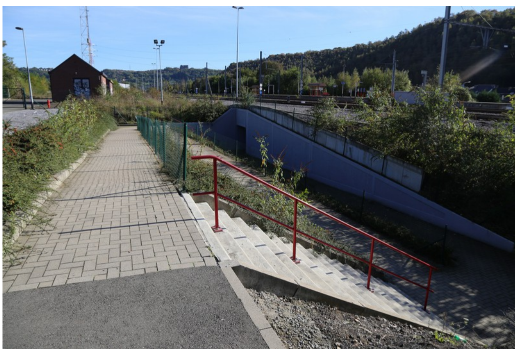
Gare de Chênée : accès côté Nord. D'où qu'on arrive, un long couloir en béton est la seule voie d'accès au quai. Particulièrement peu rassurant en soirée.
